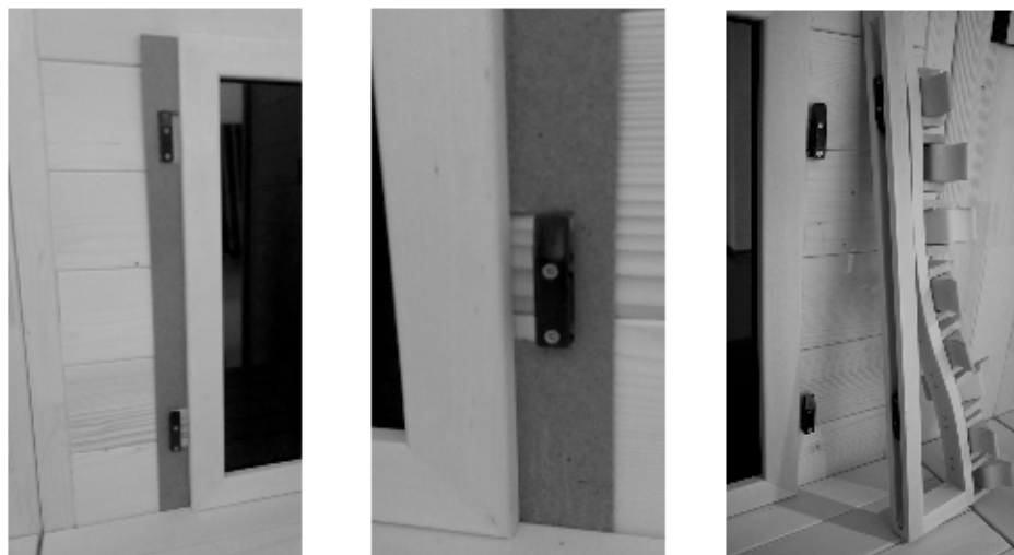
Fig. 50: Montagem dos encostos
