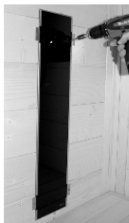
Fig. 37 : Monter le radiateur arrière (radiateur infrarouge ECO 350)
