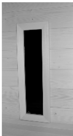
Abb. 38: Blende der Rückenstrahler montieren
