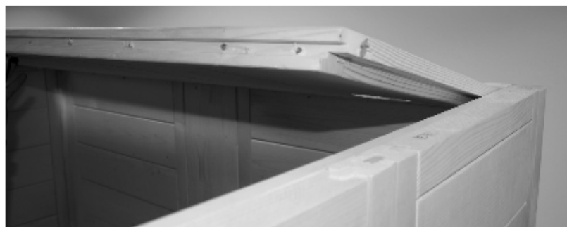
Fig. 18: Inserção dos elementos de teto da frente
