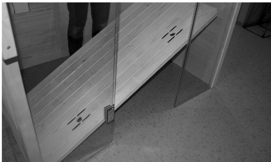
Fig. 27: Inserimento del pavimento della cabina
