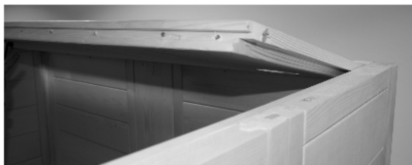
Abb. 18: Einlegen Dachelemente vorne
