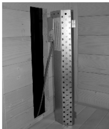
Abb. 37: Rückenstrahler (Infrarot-Strahler ECO 350) montieren
