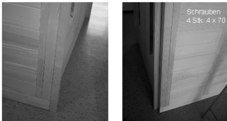
Abb. 47: Montage Abstandleisten Rückwand
