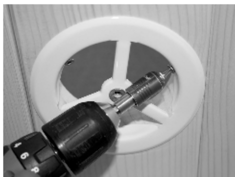
Fig. 36: Montagem da ventilação
