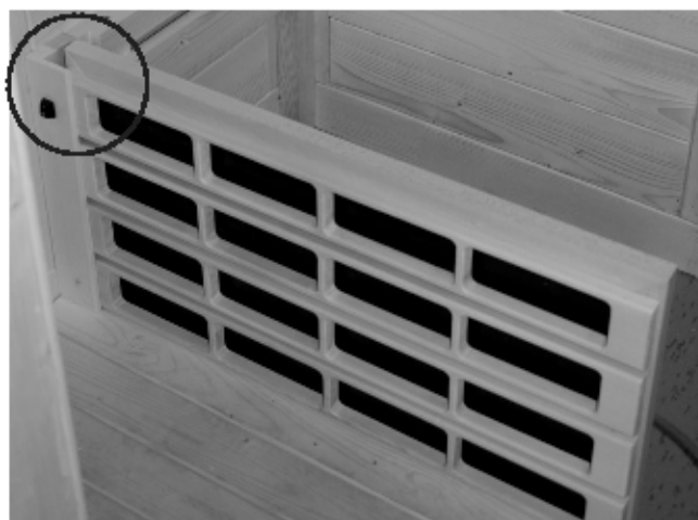
Abb. 33: Einsetzen der IR-Wärmeplatte VitaMy 164
