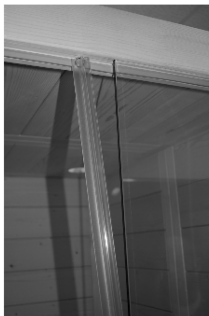
Fig. 20 : Positionnement du joint de la porte
