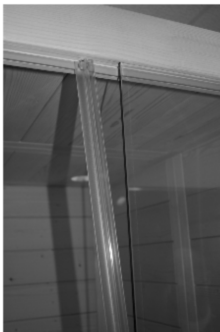
Abb. 20: Aufsetzen der Türdichtung
