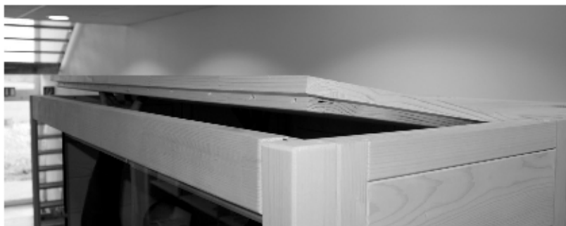
Afb. 18: Plaatsen van dakelementen voorzijde
