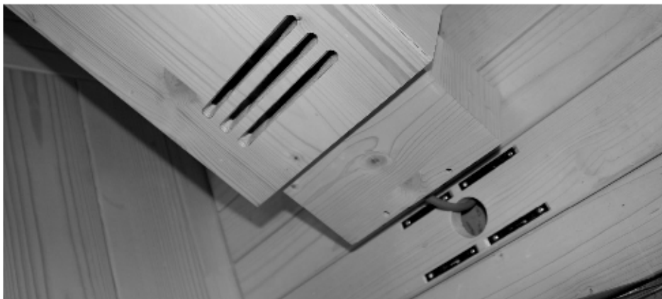
Abb. 28: Frontstrahler fixieren
