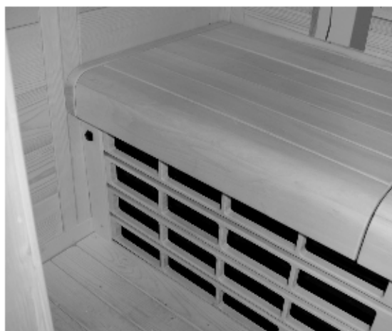
Fig. 36 : Pose du banc
