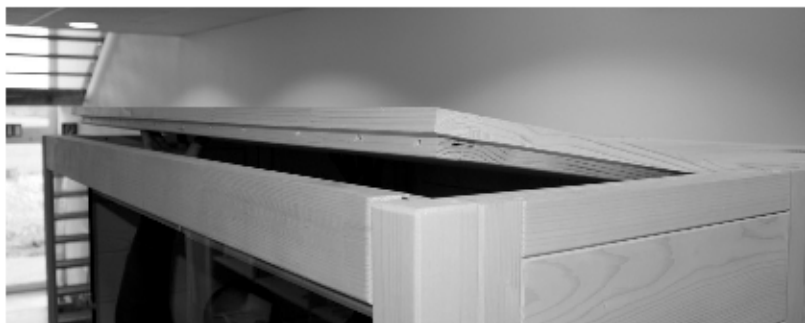
Fig. 18: Inserção dos elementos de teto da frente
