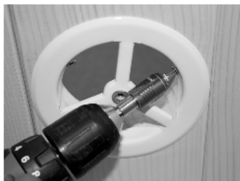
Abb. 35: Montage der Entlüftung
