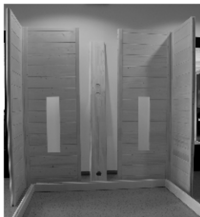
Fig. 5: Montagem na armação do chão
