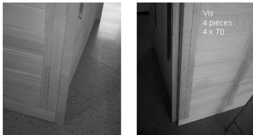
Fig. 47 : Montage des barres d'écartement paroi arrière
