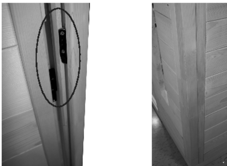
Abb. 4: Wandelemente mit Ecksteher verbinden
