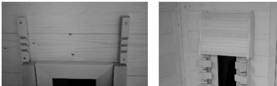
Fig. 49: Montagem dos apoios de cabeça
