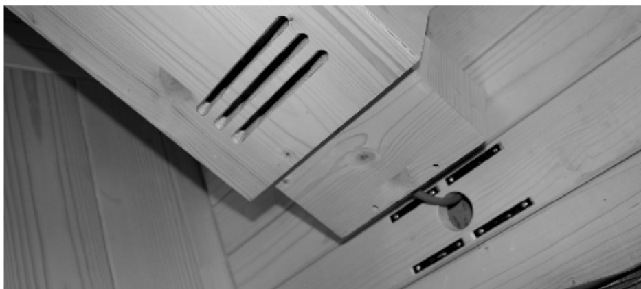
Fig. 29: Fixar o radiador frontal
