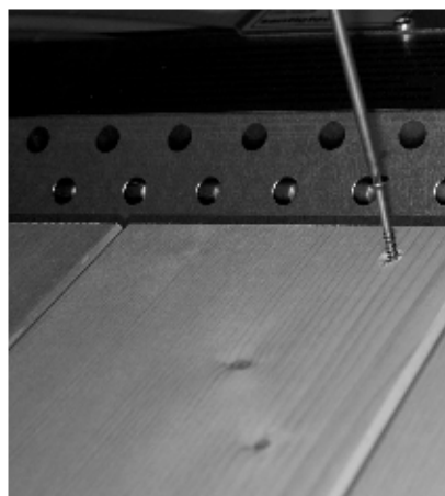
Fig. 38: Montaggio della mascherina degli irradiator posteriori
