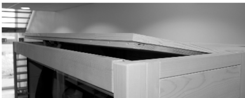
Abb. 18: Einlegen Dachelemente vorne
