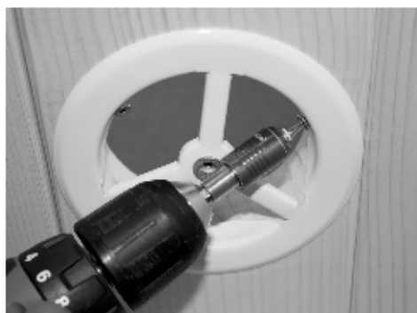
Fig. 35 : Montage de la ventilation
