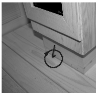
Fig. 30 : Insertion des coupelles en pierre ollaire
