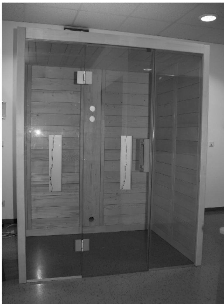
Abb. 26: Fertige Kabinenwände und Dachelemente
