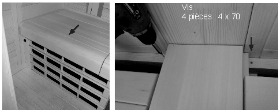
Fig. 46 : Fixation du banc
