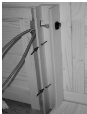
Abb. 32: Montage der U-Leisten für Wärmeplatten
