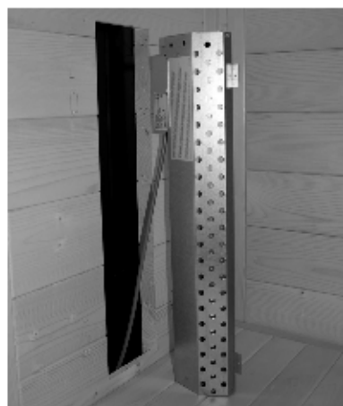
Fig. 37 : Monter le radiateur arrière (radiateur infrarouge ECO 350)
