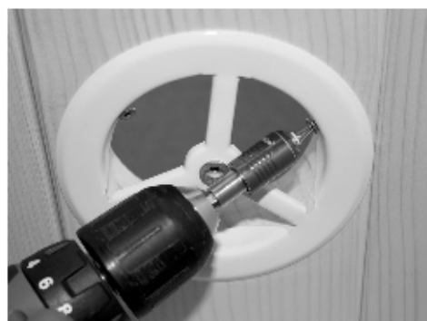
Fig. 35: Montaggio della ventilazione
