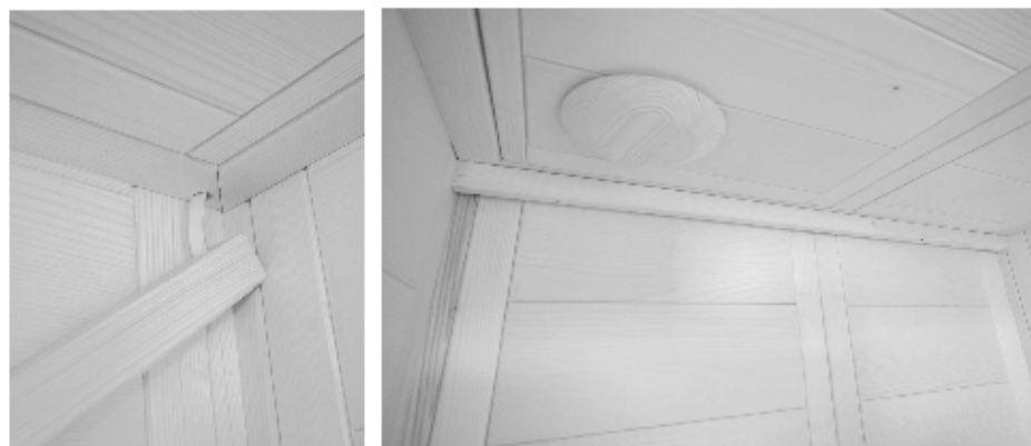
Fig. 43: LED-Leiste fixieren
