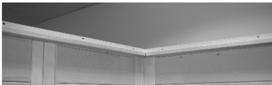
Abb. 17: Einlegen Dachelement hinten mit Lüfterausschnitt
