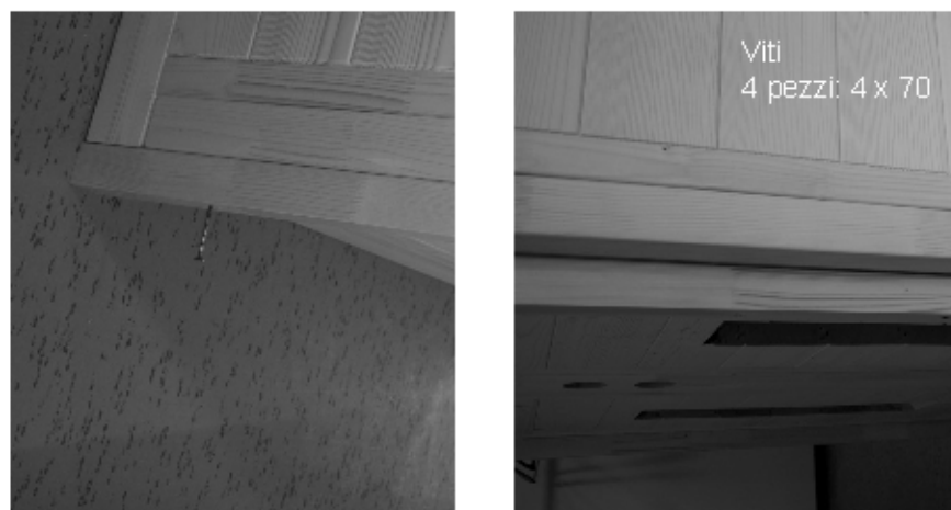
Fig. 47: Montaggio dei listelli distanziatori sul pannello posteriore
