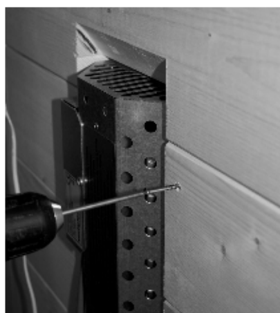
Fig. 38 : Monter le cache du radiateur arrière
