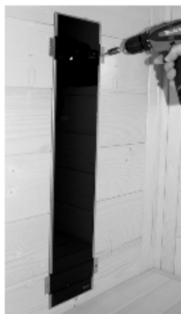
Abb. 37: Rückenstrahler (Infrarot-Strahler ECO 350) montieren
