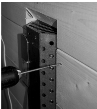
Abb. 38: Blende der Rückenstrahler montieren
