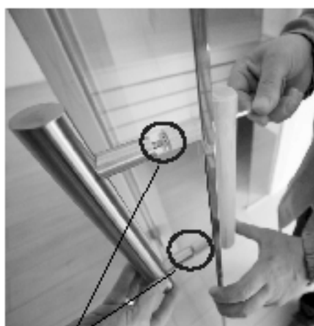
Kunststoff Beilagscheibe bei Niro-Griff beilegen
