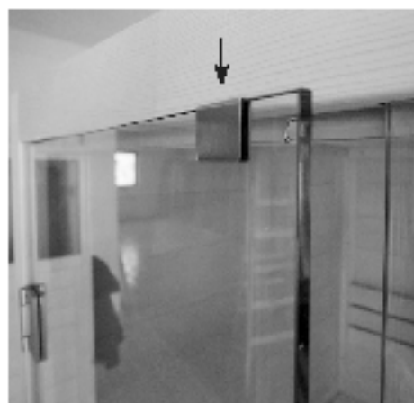
Inserir a anilha plana de plástico no puxador de aço inoxidável
