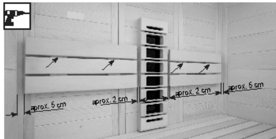
Broca de 3 mm, 4 parafusos de 4 x 70 mm
