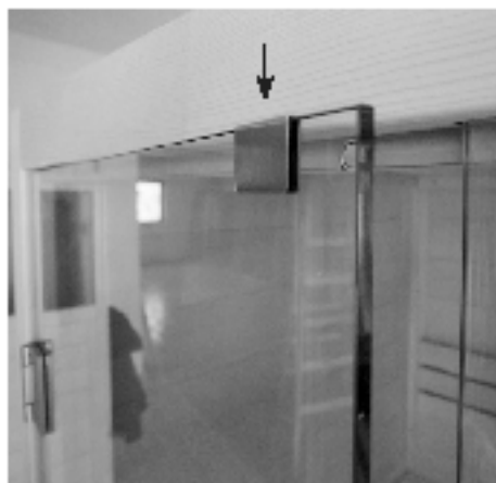
Kunststoff Beilagscheibe bei Niro-Griff beilegen
